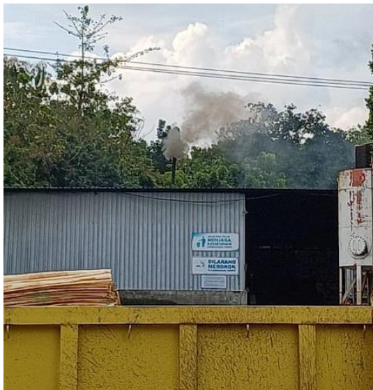
Gambar 25. Dokumentasi Cerobong Asap Hari Ke-4
