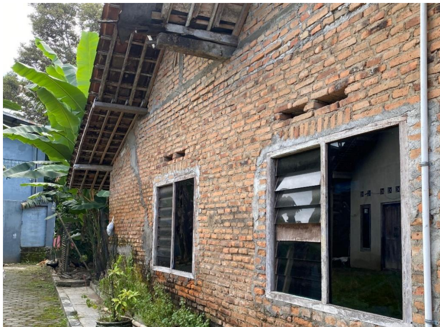
Jendela dan ventilasi rumah salah satu penderita TB di wilayah Puskesmas Mlati II Tahun 2024. (19 Mei 2025 pukul 09.00 WIB).
