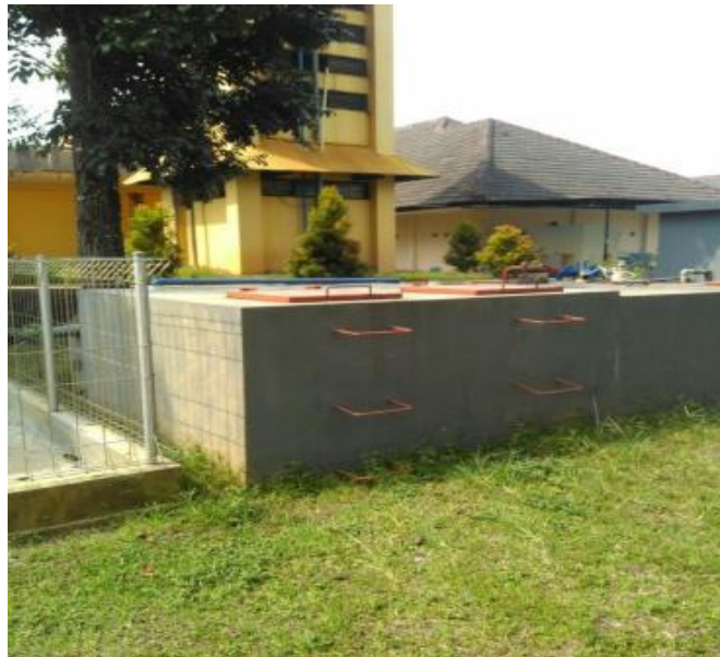
Gambar 8. Bak Groundtank Reservoir 1 pada WTP RS Jiwa Grhasia DIY
