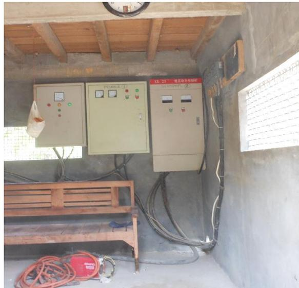
Gambar 4. Panel Listrik Penggerak Mesin Penggiling Batu
