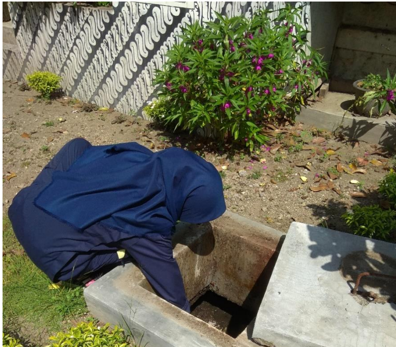
Gambar 3. Pengambilan sampel air limbah pada inlet IPAL RBC
