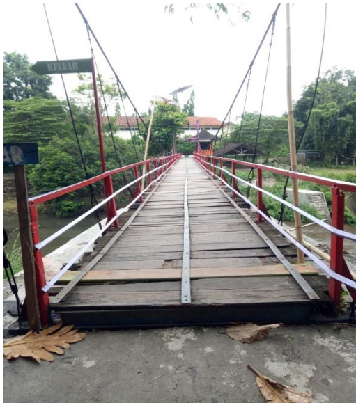
Gambar 8 Kondisi jembatan penyebrangan untuk ke kolam renang
