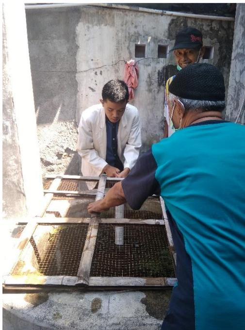
Gambar 3. Proses pemasangan klorin difuser
