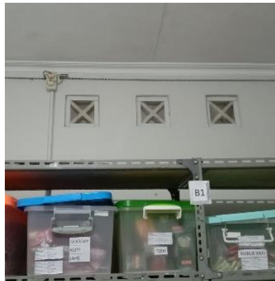
Gambar 12. Ventilasi ruangan berkasa
